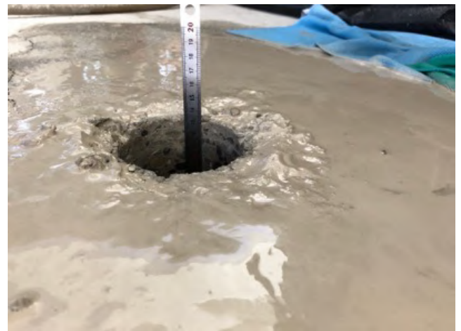
Expertise physico-chimique d'une chape de béton (Expertise judiciaire - 2018 et 2021)
