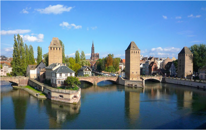
Diagnostic sanitaire des ponts Couverts à Strasbourg (Ville de Strasbourg - 2020 et 2018)
