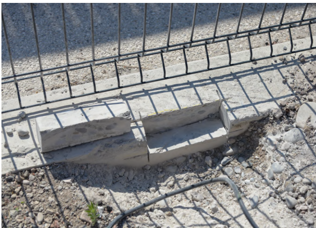
Analyses des paramètres constitutifs de longrines en béton d'un lotissement (Expertise en bâtiment - 2019)
