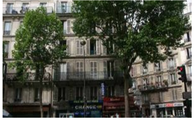
Dosages et identifications de sels sur des bâtiments parisiens (ECP - 2019)
