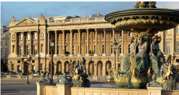
Expertise climatique de la salle Patrimoniale de l'Hôtel « le CRILLON » (Ateliers Gohard et Bouygues Constructions - 2016 et 2015)
